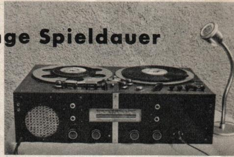
Das beschriebene Magnetbandgerät arbeitet mit 19 cm/s Bandgeschwindigkeit. Die Spieldauer ist bei Verwendung von Halbspurköpfen 3 Std. für das 1000-m-Band.
